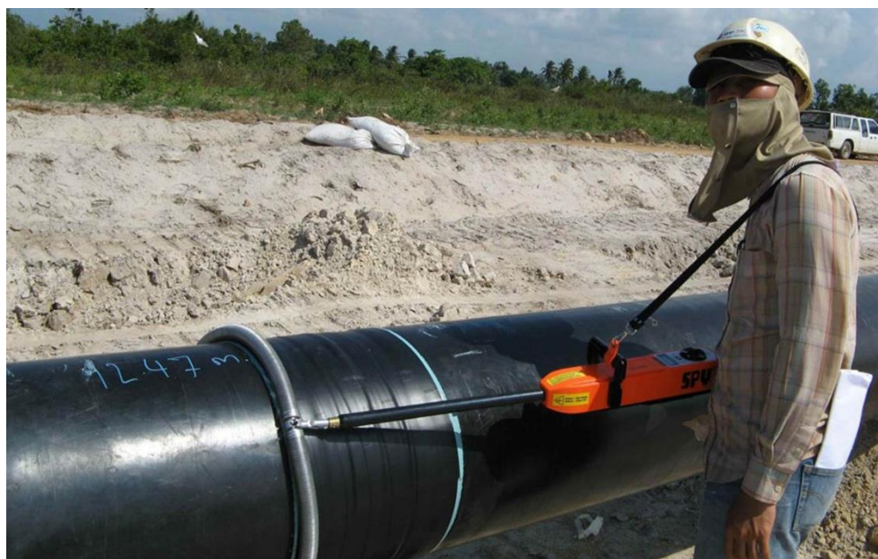
รูปที่ 2.7-2 : การตรวจสอบสารเคลือบผิวท่อภายนอกด้วยวิธี Holiday Test
